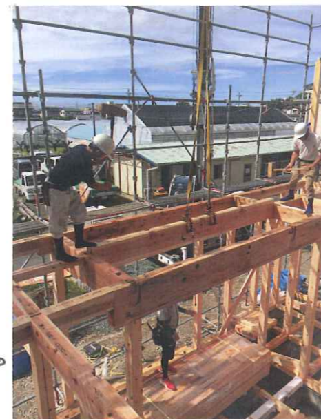
天竜杉 の梁材を 据え付け時。
